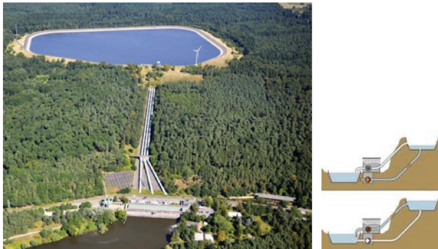
Figura 2: Esquema de funcionamiento central Reversible.
